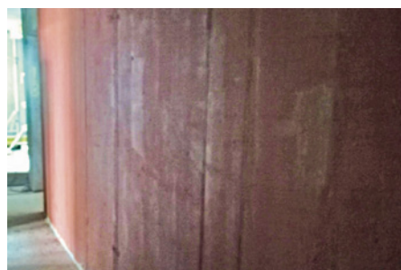
Zdjęcie 1. Ściana masywna żelbetowa pokryta gruntem
